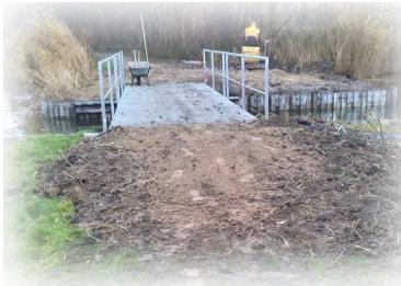
Im Spätsommer wurde begonnen den schon lange geplanten zweiten Durchbruch zum Laichbecken zu erstellen, neue Spundwände und die Brücke wurden gesetzt.
